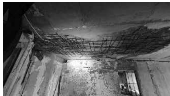
Рисунок 2 Наслідки тривалої дії вогню на монолітне залізобетонне перекриття.
