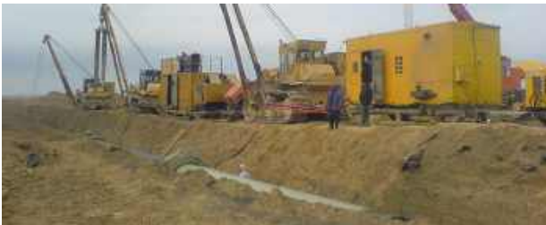
Рисунок 2. Ремонтні роботи нафтопроводу
