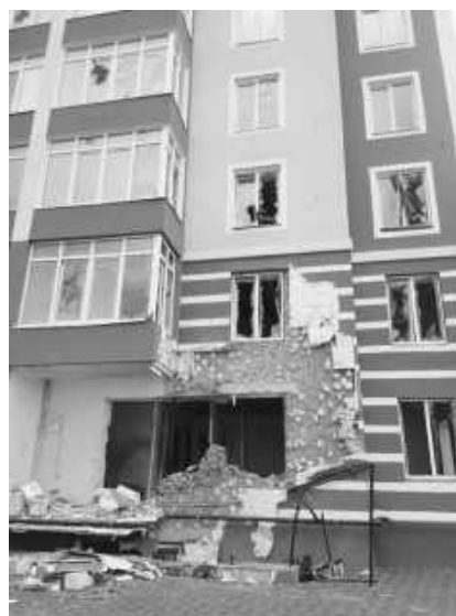
Рисунок. 2 Повне руйнування перестінку.
