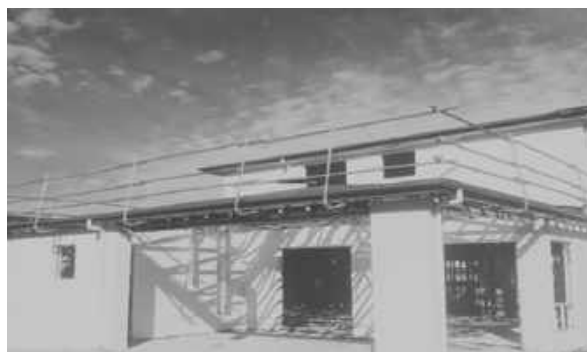
Рисунок 2. Огородження ділянки робіт за допомогою кріпильних систем
