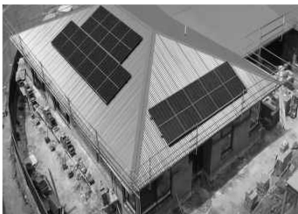
Рисунок 1. Використання елементів кріпильних систем для захисту від падіння при монтажі сонячного енергопостачання
