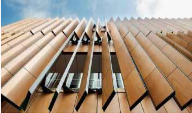
Рисунок 2. Загальний вигляд зовнішніх вертикальних жалюзі
