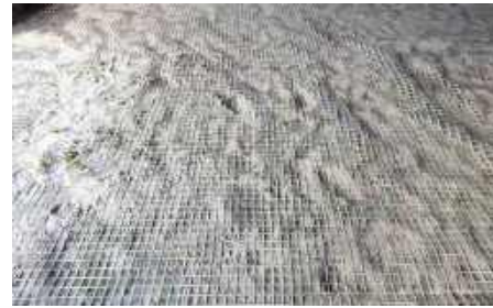
Рисунок 3. Вкладання георешітки
